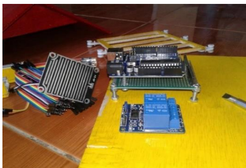
Gambar 4. Pemasangan sensor hujan
