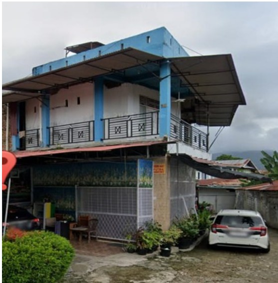
Gambar 1. Kondisi bangunan rumah kost yang dinilai
